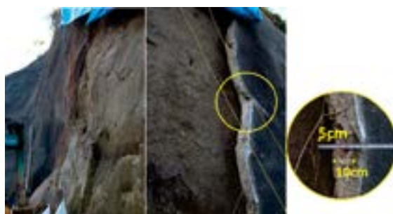
写真4 左側(南側)・右側(北側)モルタル切断面と背後地盤との間の状況 (3月22日撮影)
