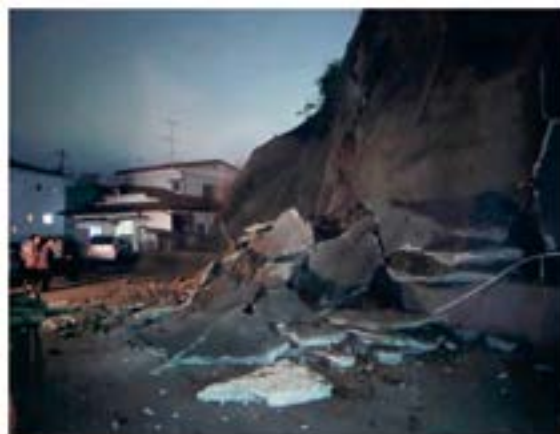
写真2 塩竈市芦畔町の法面崩壊現地 (3月20日18:21 近隣住民撮影)
