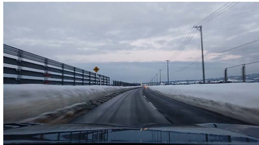
写真5-20 2025/1/11 16:35 平川市内 (大雪で吹雪吹き払い柵の下部に堆積した 積雪は今後排雪作業が必要となる。)
