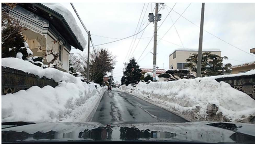
写真5-19 2025/1/11 15:08 平川市内 (1.5車線ですれ違えない箇所もある。 落雪の危険が認められる。)
