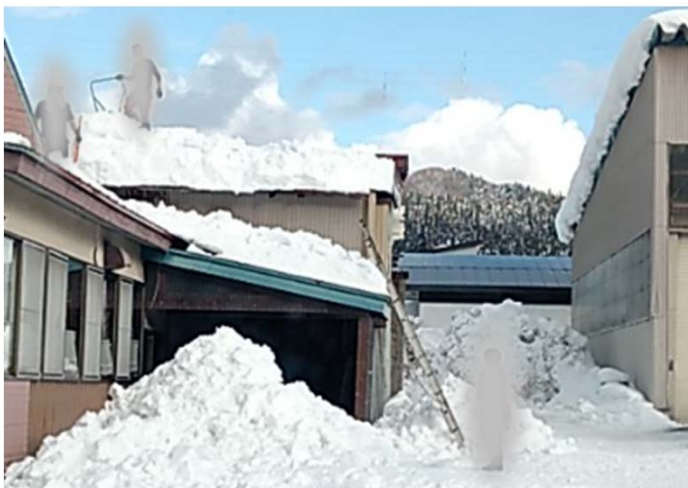
写真5-17 2025/1/11 14:36 平川市 (屋根雪下ろし作業。)
