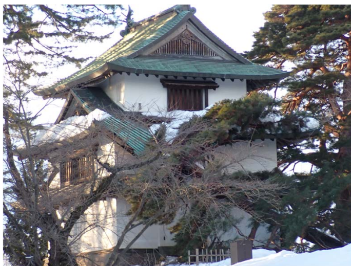
写真5-27 2025/1/13 16:05 弘前公園 (針葉樹(マツ)の倒木により被害を受けた 築400年の弘前城二の丸末申櫓。)
