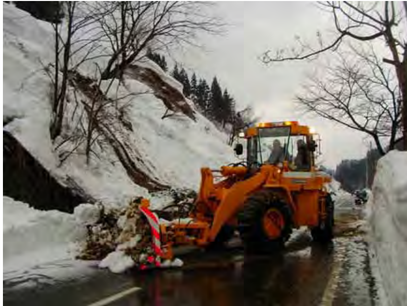
重機による除雪
