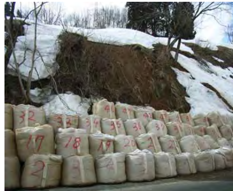
トンパックによる崩落防止
