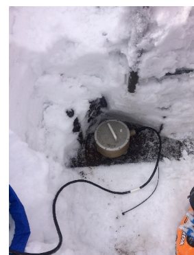
雪崩の運動や発生を測定する装置 斜面に設置した雪崩の内部構造測定用センサ(左) 雪崩発生を検知するための地震計(右)
