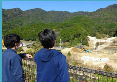
那智勝浦町市野々小学校近くの砂防堰堤を改修している工事現場
