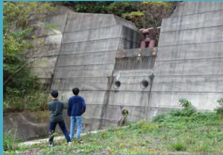
日高川町立山野小学校近くの砂防堰堤
