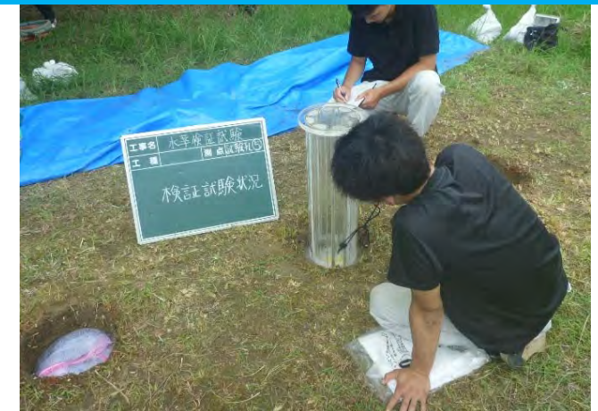
写真-7 透水試験の様子
