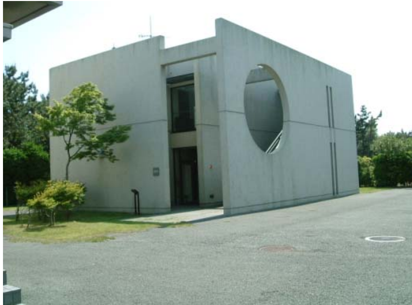
(5) 相模湾ケーブル式海底地震観測網海岸中継局舎（平塚海岸中継局舎）
