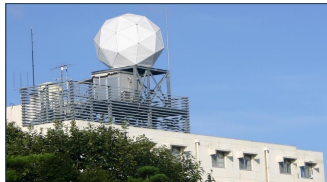
2003年に神奈川県海老名市に設置したM Pレーダー
