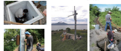
タール火山の地震計・空振計・GPS・磁力計設置作業
