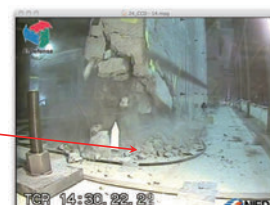
大地震で壁の足元が破壊している
