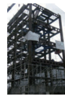
骨組の製作工事 (現場溶接接合)
