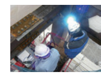
骨組の製作工事 (現場溶接接合)
