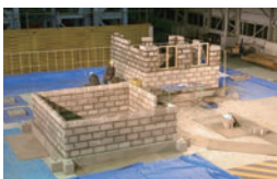
2月24日のブロック組構造住宅振動台実験の試験体製作
