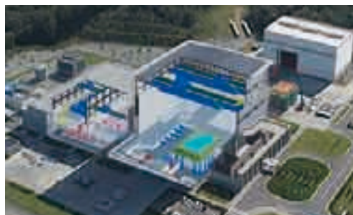
図1 E-ディフェンス全景
