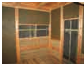
土壁施工中のB棟1階
