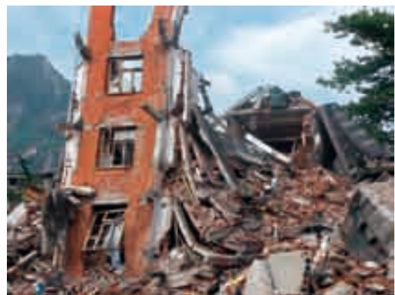
写真3 山地と平野の境界における漢旺(Hanwang)鎮(X度、表紙を参照)は綿遠河の沖積平野に位置し、数多くの建物が倒壊して、死者が500人以上に達しています。
