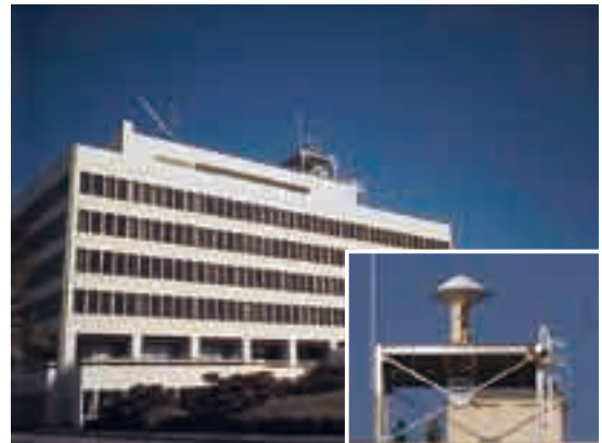
写真1 千葉県木更津市役所の屋上に新たに設置されたMPレーダ (2008年)。
