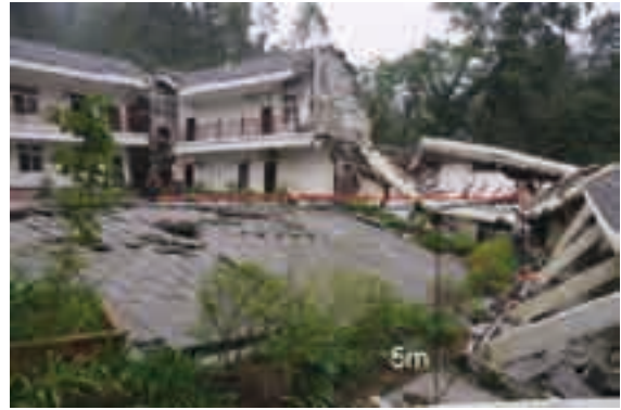
写真2 虹口(Hongkou)郷八角廟に出現した縦ずれ断層。写真が北向き。西側が最大約6m隆起した断層が新築2階建てコンクリートの招待所を破壊しました。
