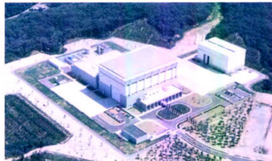
図1 E-ディフェンスの外観
