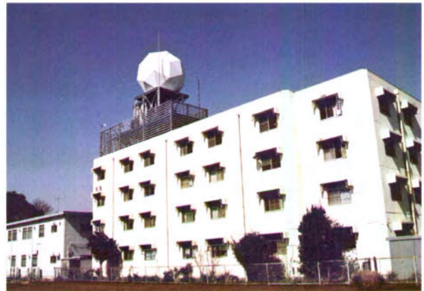
写真2 2003年に神奈川県海老名市に設置されたMP-Xレーダの外観。レーダはつくばから制御される。
