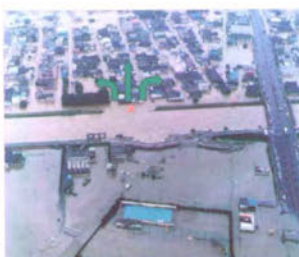
破堤と内水氾濫による浸水状況 (新川町、西枇杷島町、9/12'00)
