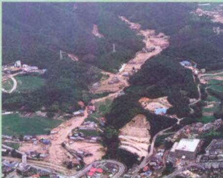
広島市佐伯区五日市町上小深川の土石流(写真:アジア航測)
