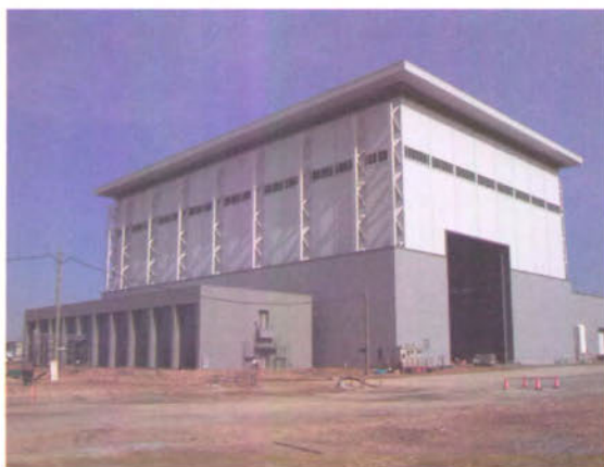
写真1 完成間近の実験棟・計測制御棟
