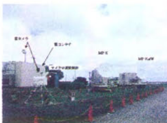
図1 雲・雨観測のためのMPレーダ観測装置。MPレーダシステムは高さ30mのMPレーダと高さ約40mの2nd MPレーダの2つの観測装置があり、2つのアンテナに接続されています。レーダは、MPレーダの中心に設置されたアルミ金属球の周囲を回転しながら観測を行います。また、レーダの周囲には、風速・風向観測装置や、降水観測装置が設置されています。
