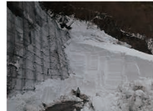
山梨県甲府市古閑国道36号沿い雪崩の調査
