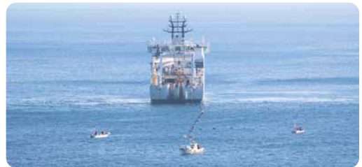
ケーブル敷設船を用いた陸揚げ作業の様子
