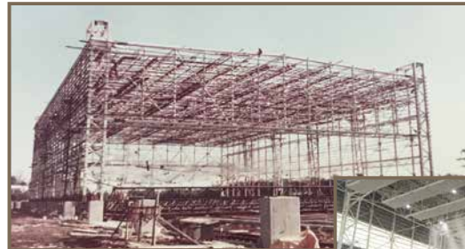
建設中の様子
