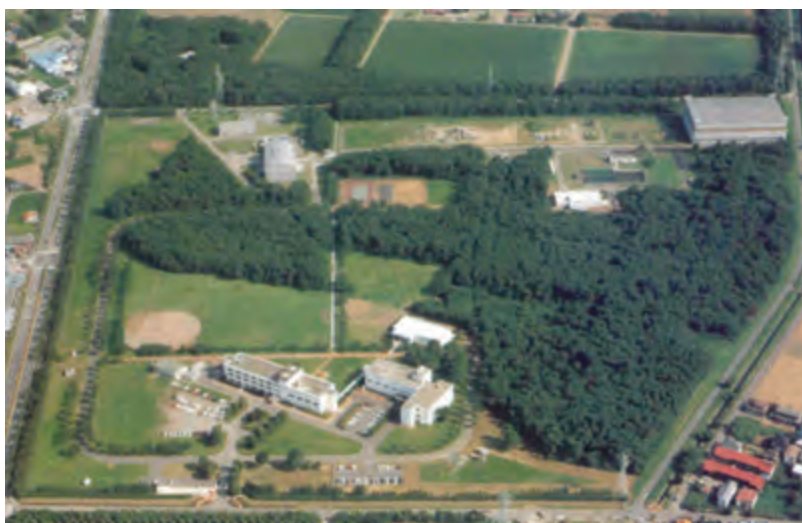
写真3 1992年頃のつくば本所（周回道路は3/4完成）
