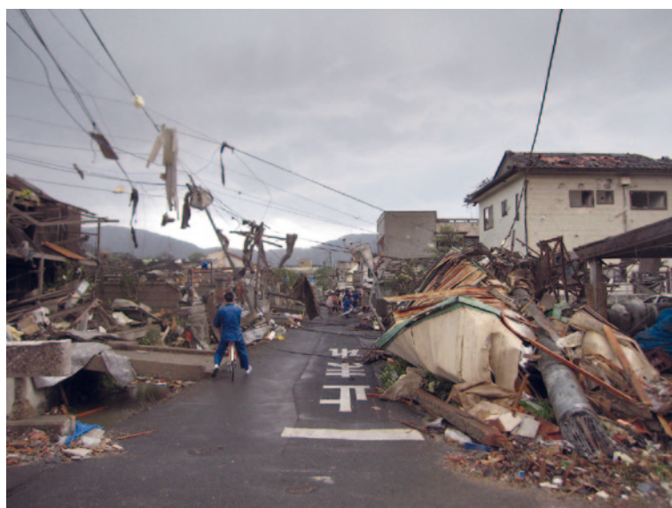
写真2 竜巻被害当日の北条の町の様子。
