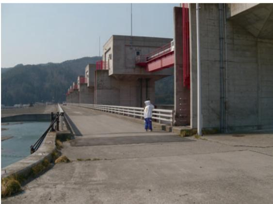
写真8 山側から見た小本水門。普代水門に見られたような連絡用の道路橋の損傷(写真12)は見られない。つまり、津波がほとんど越流しなかったことを示している。
