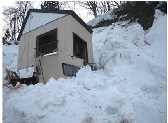
図3 地震による雪崩によって被災した建物（新潟県十日町市）
