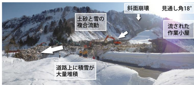
図6 地震によって発生した土砂と雪の混合流による被害(新潟県津南町)
