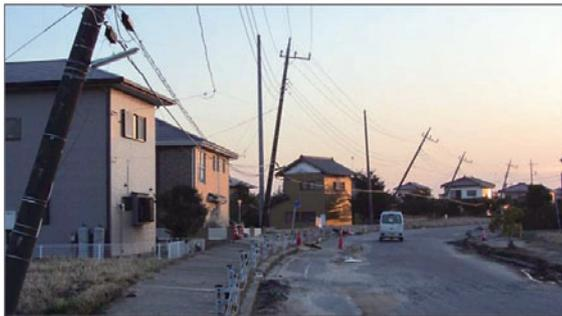
写真2 干拓地のほぼ全域で液状化が発生し、多くの電柱が傾いた様子(潮来市日の出)
