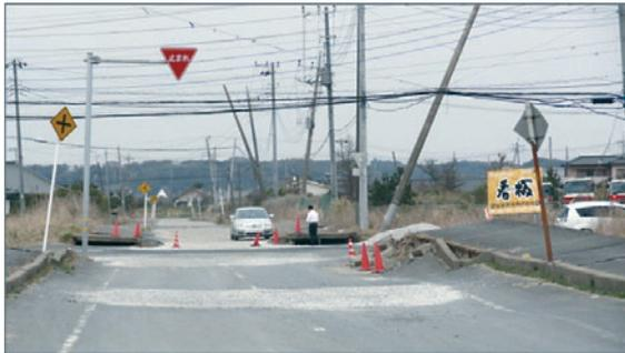
写真1 歩道下の水路の浮き上がり、電柱の傾斜(神栖市平泉)
