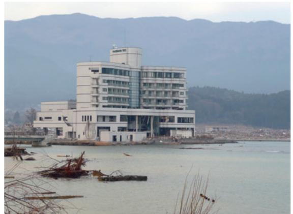
写真1 陸前高田市の海沿いに建つホテル。5階近くまで損傷が見られる。
