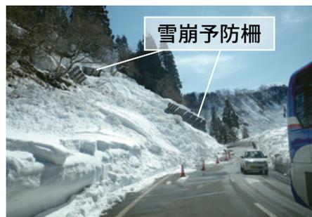
図5 雪崩予防柵上部斜面から発生した雪崩が道路を埋めた状況(新潟県十日町市)
