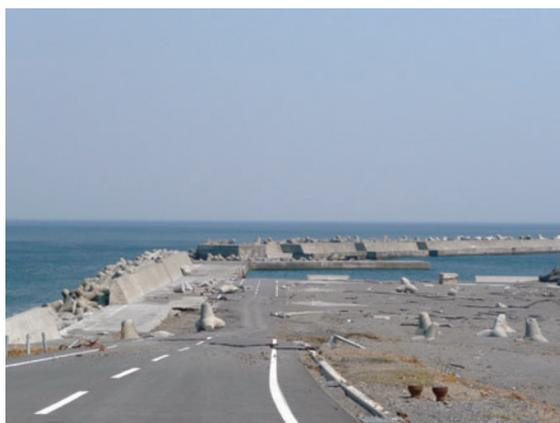
写真9 破堤した海側の防潮堤と津波により数10m流された20tのテトラポット。この場所の陸側にもうひとつ防潮堤(写真10)がある。
