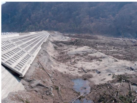
写真10 小本水門に隣接する防潮堤。防潮堤脇が津波により洗掘されている。
