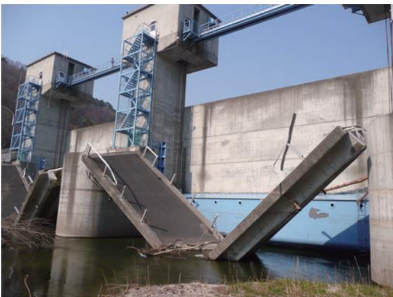
写真12 山側から見た普代水門。越流した津波により連絡用の道路橋が損傷している。小本地区よりも津波高が大きかったことを示している。
