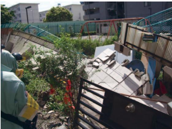
写真1 平成22年7月5日豪雨による被害の例。氾濫した水の圧力によってブロック塀やドアが倒されています。
