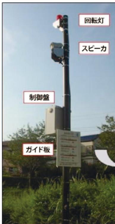
写真2 いたち川（横浜市）に設置されている警報装置
