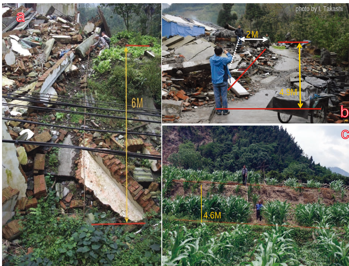
写真1 映秀—北川断層帯 YX-BC に沿う典型的な逆断層。(a) 後深溝(HS)では、最大6mの縦ずれが民家と庭に現れた。(b) 高川(GC)では、4.9mの縦ずれが民家と道路に現れた。(c) 擂鼓鎮(L)では、西側の畑が約4.6m隆起した。場所は図1に示す。
