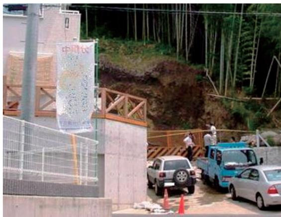
写真1 造成中の宅地における土砂災害の例
