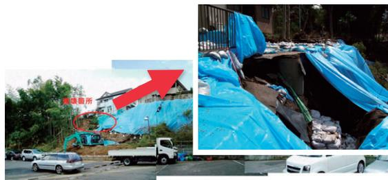
写真2 工事中の斜面が雨で崩れた例
