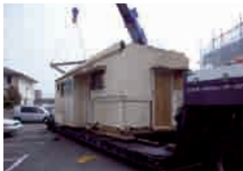
図7 移築作業
