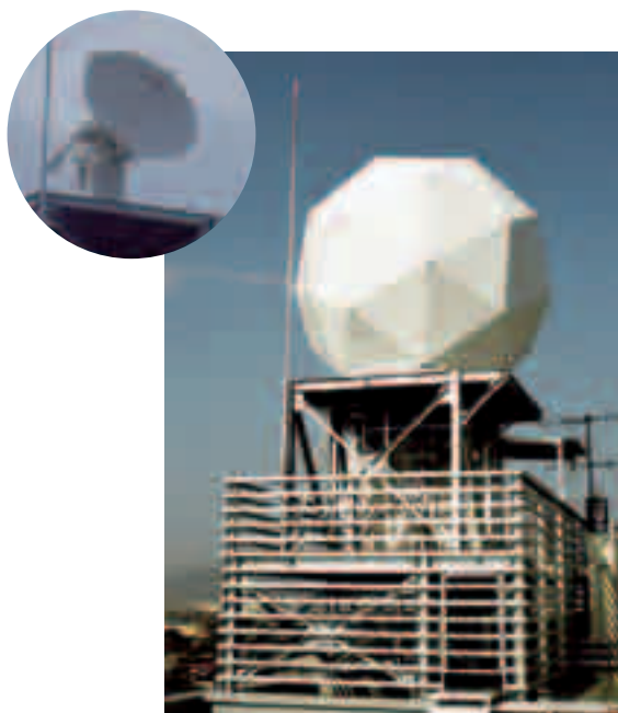
図1 海老名市に設置されたMP-Xレーダ。 丸内は、レドーム（ドーム状の保護覆い）を被せる前の写真。
