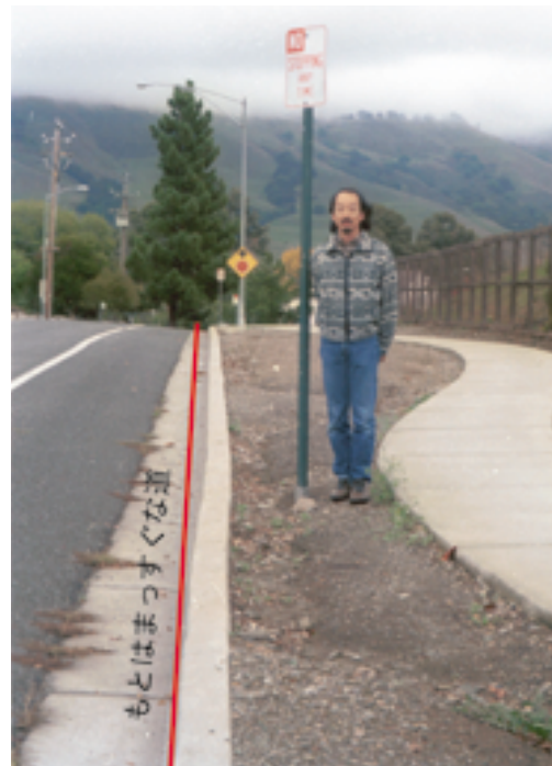
図1 ハイワード断層を巡検中の筆者。ハイワード断層は、地震時に急激に動くだけでなく、常に非常にゆっくり(毎年数mmから数cm程度)と滑っている(クリープ)ため、頻繁に補修をしているにもかかわらず、緑石が波打っているのが分かる。
