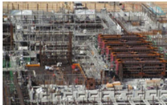
水平加振機固定埋設金物の設置状況（平成13年4月24日）
