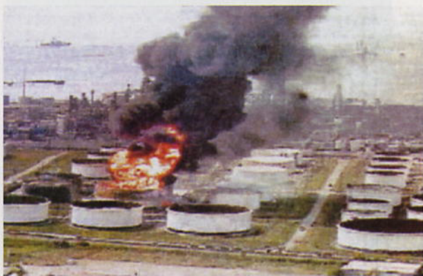
図1 タンク被害（トルコ地震） ※Bogazici University HPより引用
