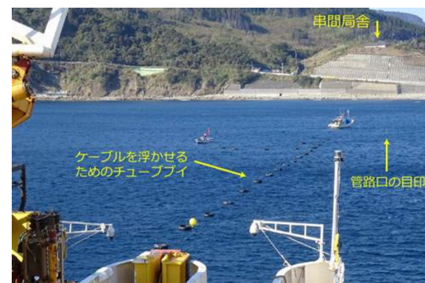
ケーブル陸揚げ作業（宮崎県串間市）
