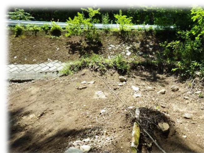
写真3 法面の土砂崩落
