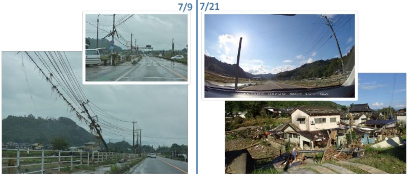
球磨村渡地区:傾いた電柱、電線に残った漂流物(草、木、枝、瓦礫)【7月9日撮影】
