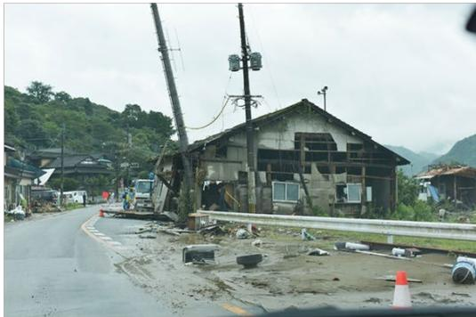
球磨村渡地区:90度時計回りに回転し、15m流下、電柱に衝突して停止した建物【7月9日撮影】
