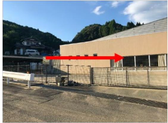
Figure 30 球磨村千寿園の浸水痕跡
