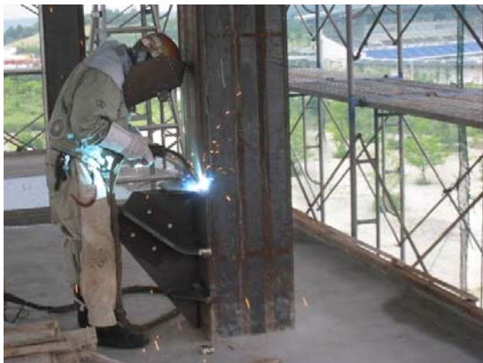
制振ダンパー取り付け部の現場溶接
