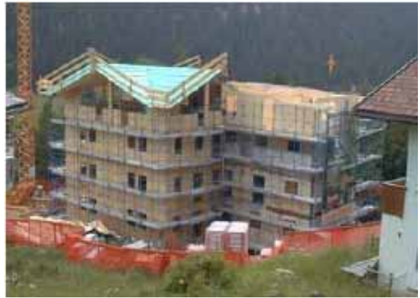
ヨーロッパで建設途中のクロスラミナパネル木造建物(参考写真)
